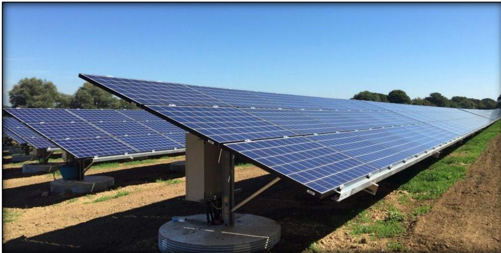
Zdjęcie 1 Przykładowa konstrukcja z zastosowaniem bloczków żelbetowych
